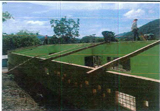
Foto1: Desmontado de estructura del Módulo I.
