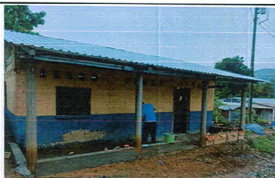
Foto 6: Fundición torta de Cemento Módulo III.
