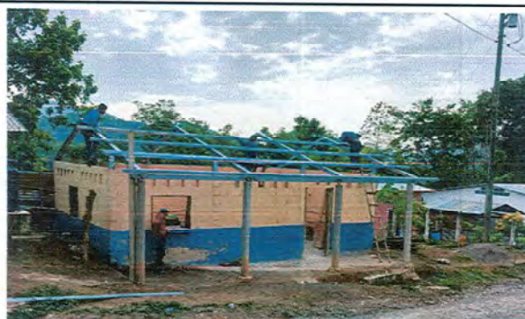
Foto 4: Montaje de estructura metálica al Módulo III.
