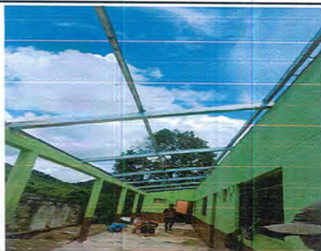
Foto 3: Montaje de estructura metálica corredor del Módulo I.
