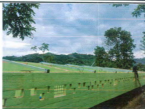
Foto 2: Montaje de estructura metálica en el Modulo I.
